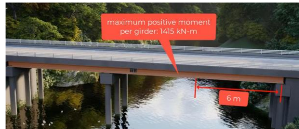
Figura 3. Resultado de Esforço Interno de Momento Máximo Positivo – Dr. Lakmazaheri.
