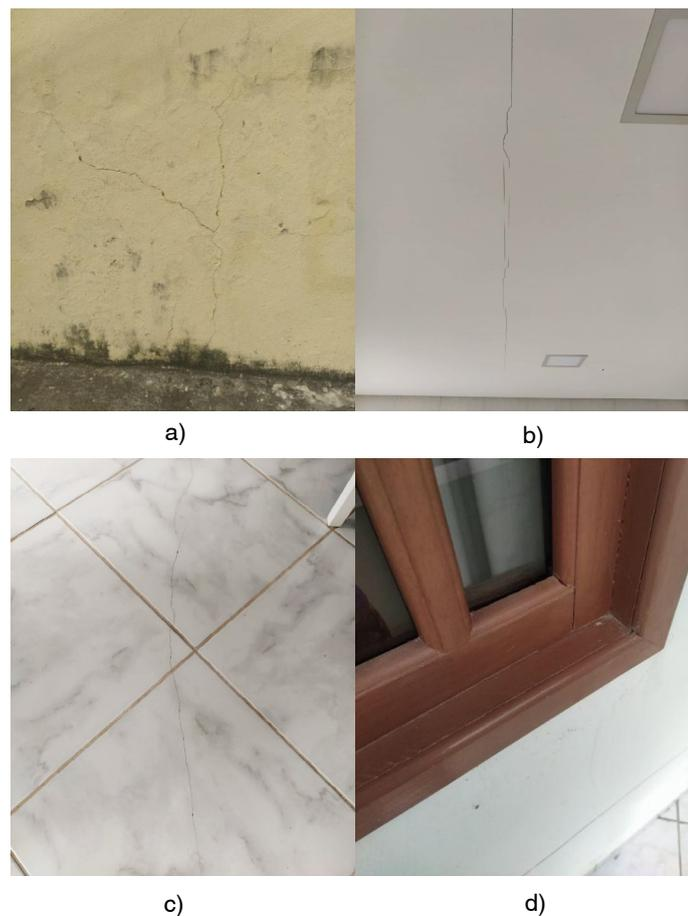
Figura 5 - Exemplos de patologias encontradas nas residências do bairro: (a) trincas em muro de alvenaria, (b) fissura em gesso decorrente das vibrações, (c) avaria em revestimento cerâmico e (d) poeira excessiva nas residências
