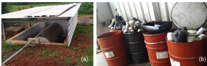
Figura 2 Tanque para armazenamento do OLUC (a) e tambores contendo embalagens e resíduos contaminados (b).
