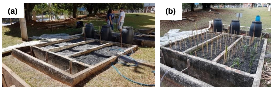
Figura 2 – (a) Preenchimento dos wetlands construídos com brita 0 e (b) Plantio das mudas nos wetlands construídos.
