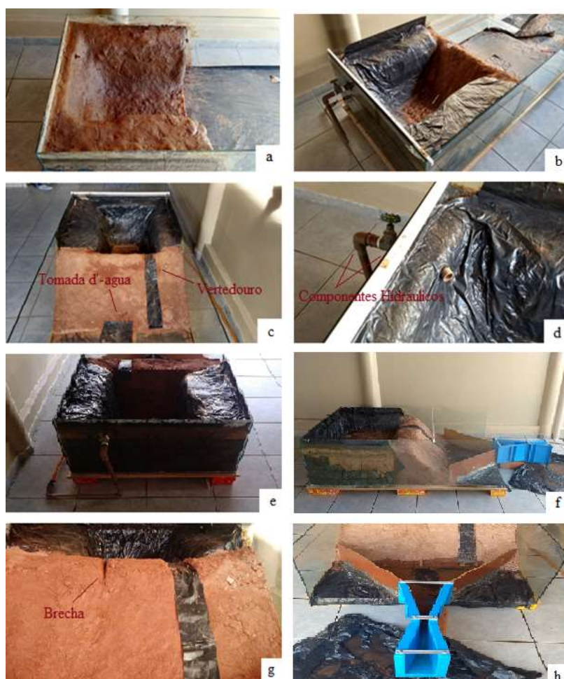
Figura 2 – Etapas da construção do modelo físico e estruturas elementares da barragem
